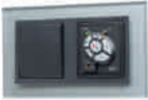
100-serien kontrollenhet, installerad tillsammans med en Simon strömbrytare
